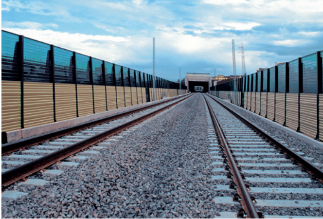
Lärmschutzwand, Hochgeschwindigkeitsstrecke Rom-Neapel
