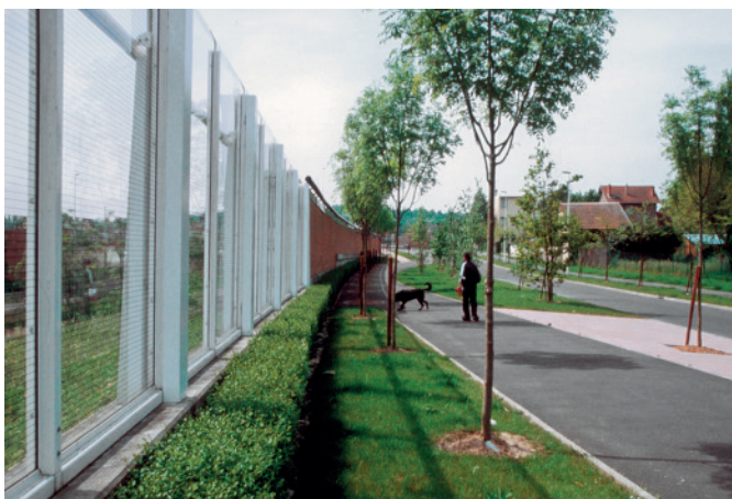
Lärmschutzwand, Boulevard Intercommunal du Parisis PLEXIGLAS® Soundstop GS CC Direction Départementale de l'Équipement, Val d'Oise
