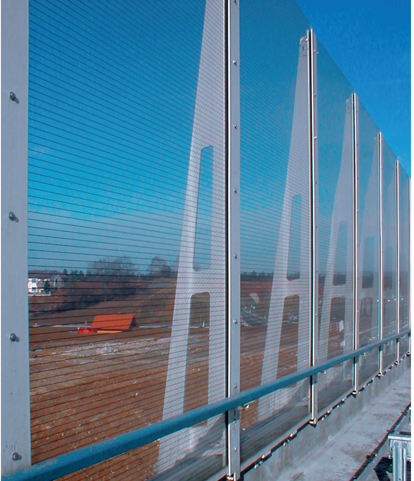
Lärmschutzwand, Autobahn A9, Trockau
