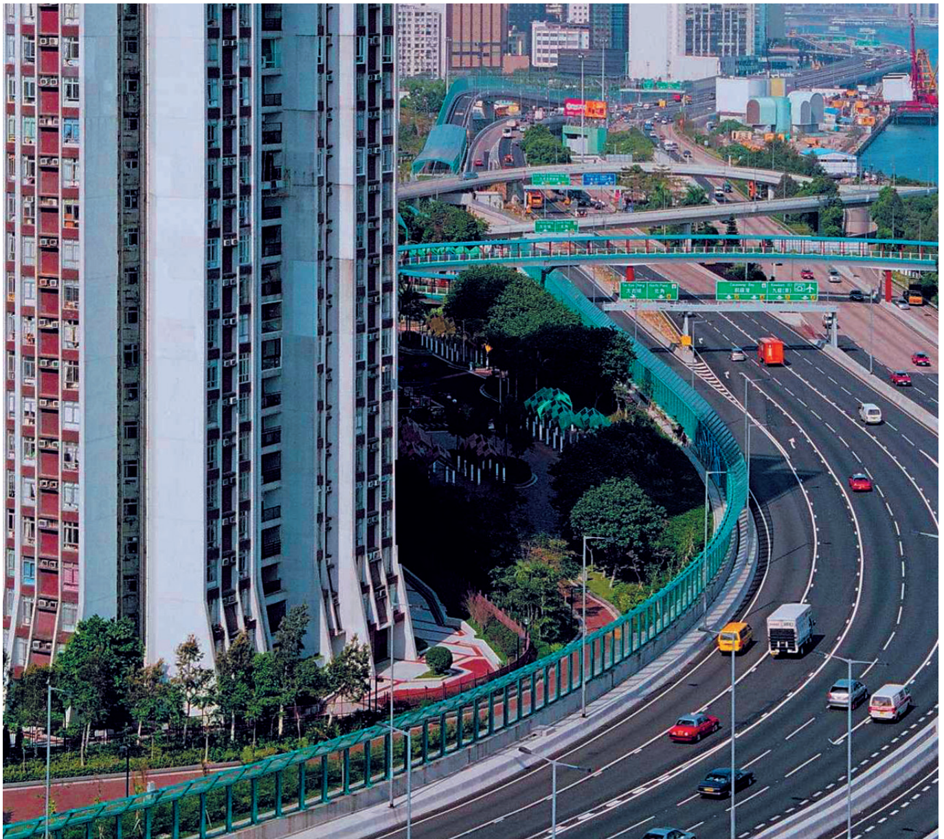
Lärmschutzwand, Lärmschutztunnel Eastern Corridor PLEXIGLAS® Soundstop GS CC und GS Active Way Ltd.
