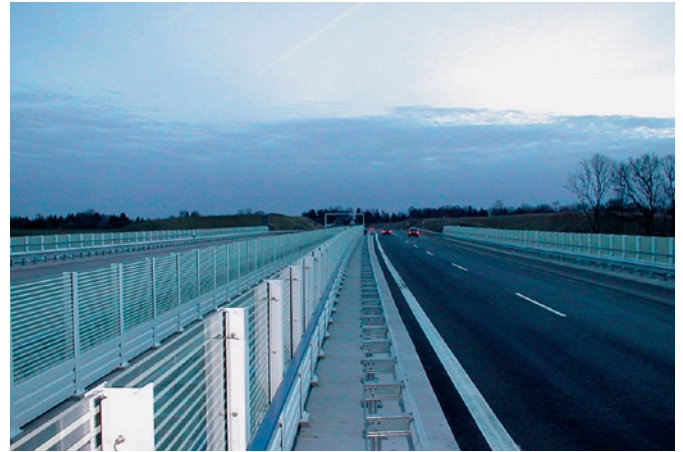
Lärmschutzwand, Travequerung, Lübeck PLEXIGLAS® Soundstop GS CC Fa. Markus Kaiser
