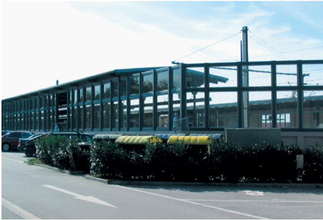
Lärmschutzwand, Bahnhof Baden Baden PLEXIGLAS® Soundstop GS CC R. Kohlhauer GmbH
