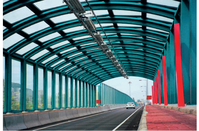
Innenansicht Lärmschutztunnel Eastern Corridor PLEXIGLAS® Soundstop GS CC und GS Active Way Ltd.
