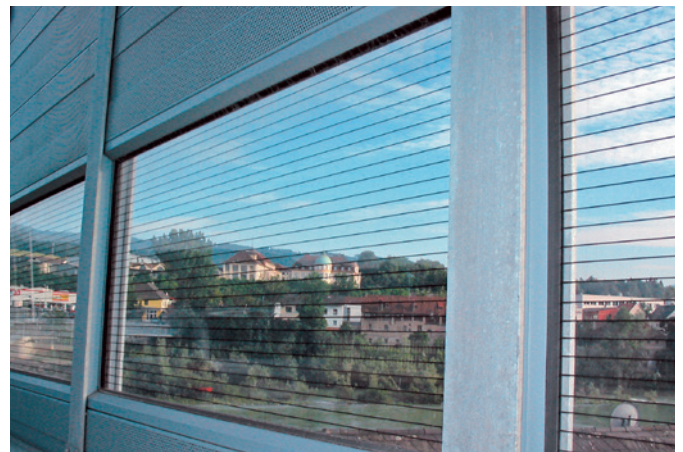
Lärmschutzwand, Rederbrücke, Steyr PLEXIGLAS® Soundstop GS CC STRABAG-Thalgau, Forster Lärmschutz Elemente, Forster Metallbau Gesellschaft m.b.H.
