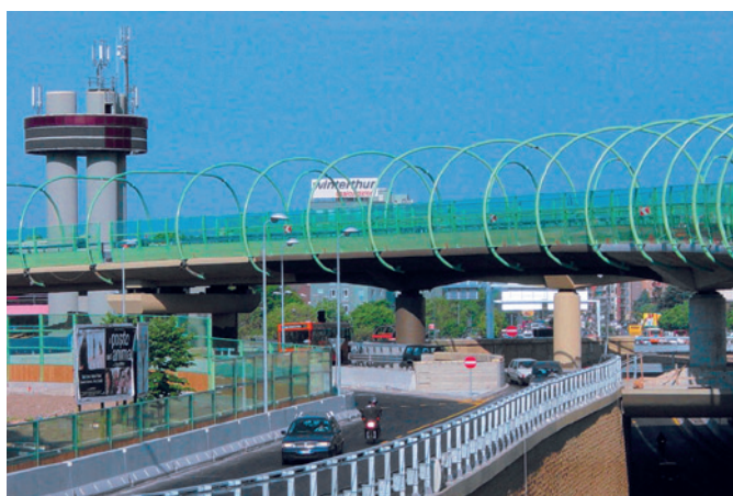
Lärmschutzwand, Piazza Maggi, Milano PLEXIGLAS® Soundstop XT Technical, Provaglio (Brescia)
