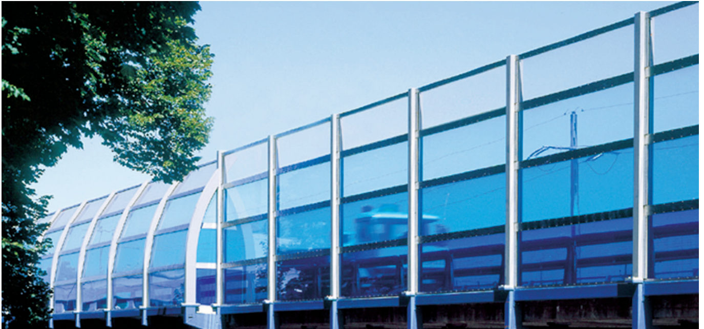
Lärmschutzwand, Autobahn N1, Morges West, Kanton Waadt
