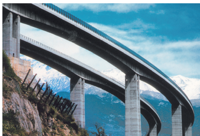
Lärmschutzwand, Brücke Turin-Frejus
