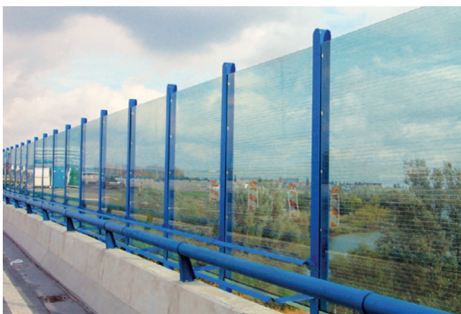
Lärmschutzwand, Praha 6, Ruzyne PLEXIGLAS® Soundstop XT SMP Construction a.s.
