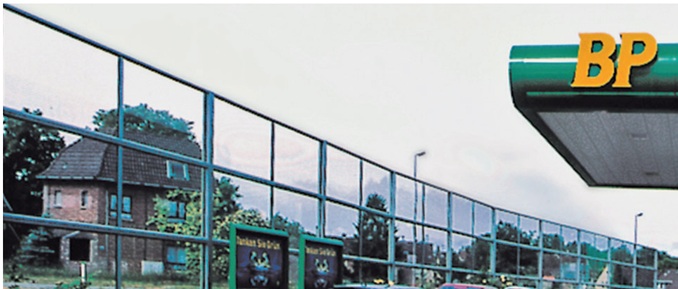
Lärmschutzwand, Tankstelle Wesseling PLEXIGLAS® Soundstop GS CC ausgeführt als Acrylglas-Kombielement Alusyston Lärmschutz GmbH
