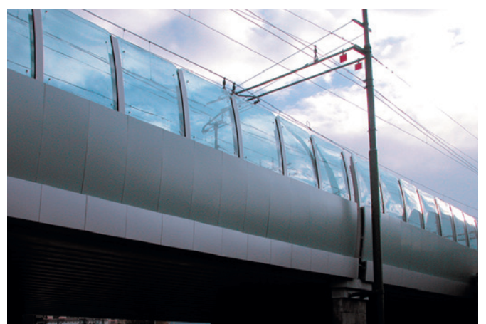
Lärmschutzwand, Ponte Roma, Bolzano
