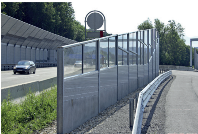
Lärmschutzwand, Autobahn A1, Steinhäusl PLEXIGLAS® Soundstop GS CC Forster Metallbau Gesellschaft m.b.H.
