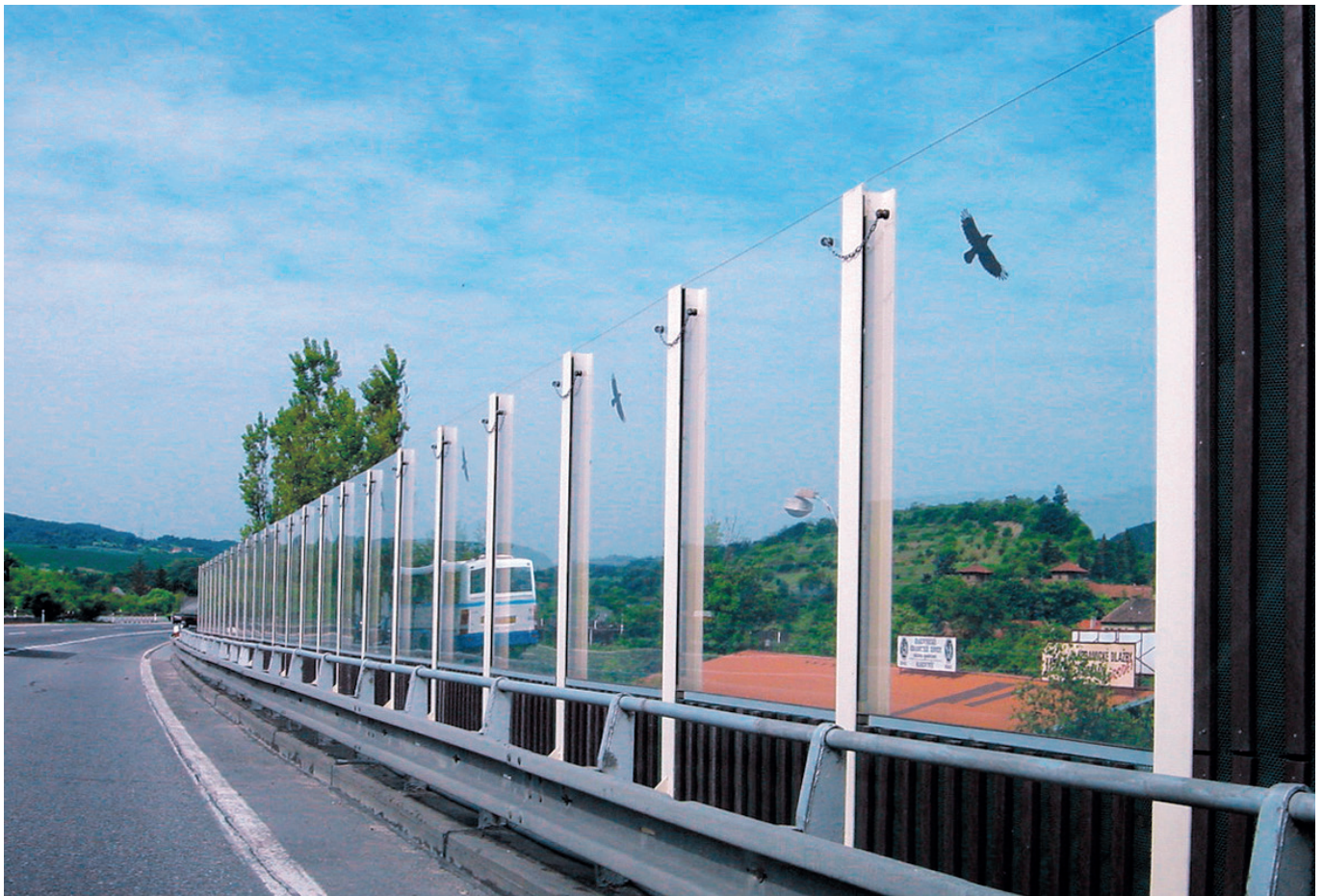
Lärmschutzwand, Motoway D5, Lodnice PLEXIGLAS® Soundstop XT Stavebni technologie
