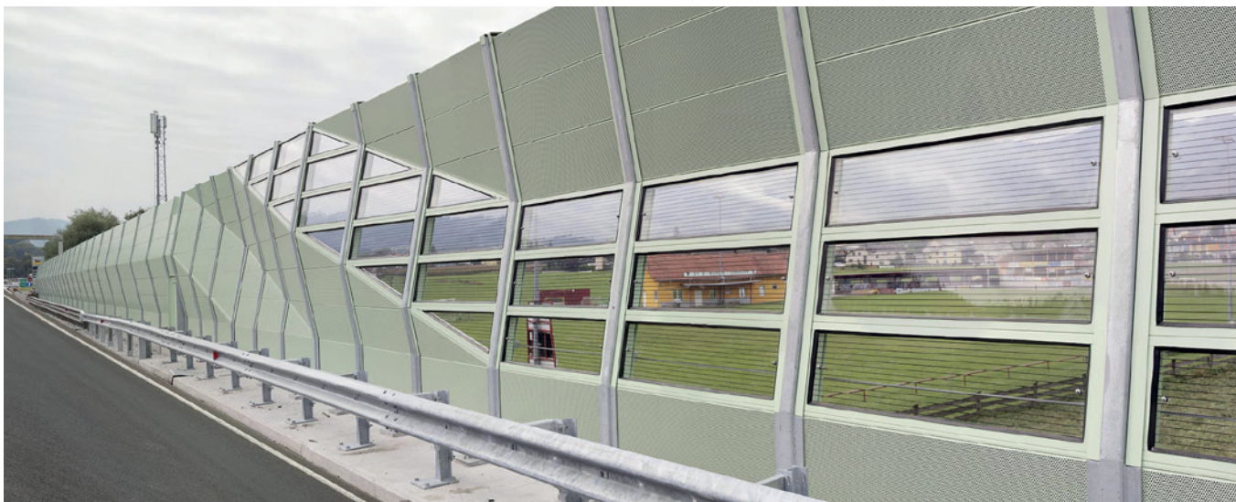
Lärmschutzwand, Regio Tram Traun Versuchsstrecke PLEXIGLAS® Soundstop GS CC Forster Metallbau Gesellschaft m.b.H. Traun
