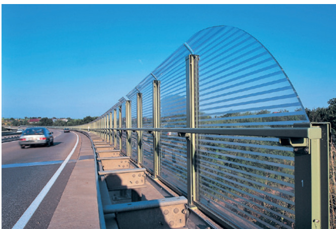
Lärmschutzwand, Eltville PLEXIGLAS® Soundstop XT
