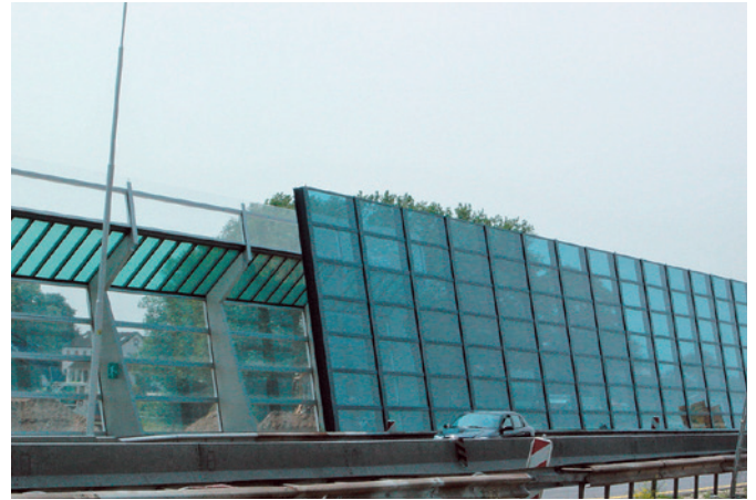
Lärmschutzwand, Autobahn A15, Tiel PLEXIGLAS® Soundstop XT Holland Scherm B. V. Rotterdam
