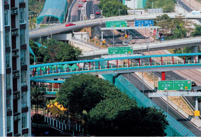
Lärmschutzwand, Lärmschutztunnel Eastern Corridor PLEXIGLAS® Soundstop GS CC und GS Active Way Ltd.
