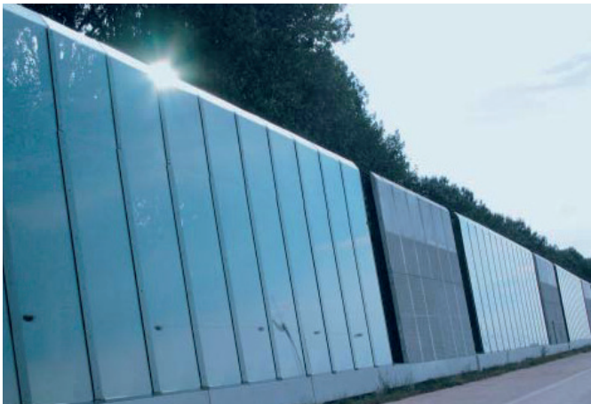
Lärmschutzwand, Autobahn A15, Gorinchem PLEXIGLAS® Soundstop XT Heijmans B. V., s'Hertogenbosch und Strukton Betonbouw, Maarsse
