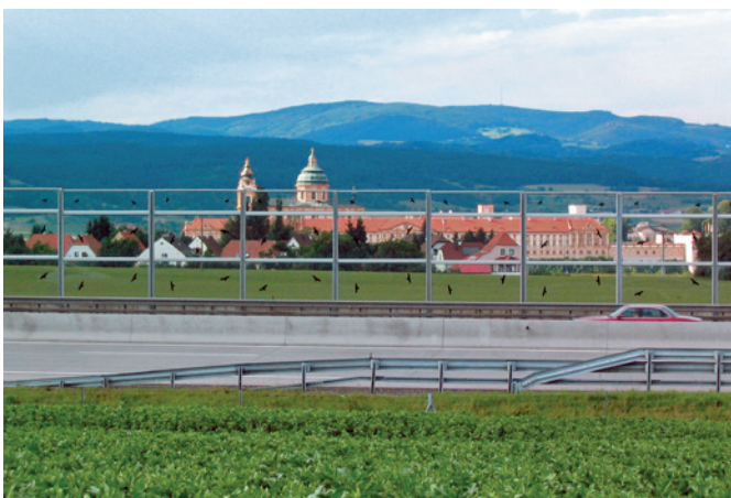
Lärmschutzwand, Autobahn A1, Melk PLEXIGLAS® Soundstop XT Alpine, Salzburg
