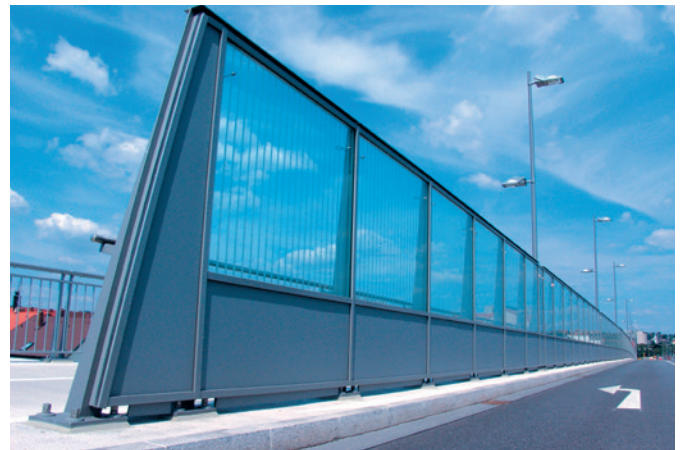
Lärmschutzwand, Nibelungenbrücke, Regensburg Sockelbereich aus PLEXIGLAS® Soundstop NT Fa. Markus Kaiser
