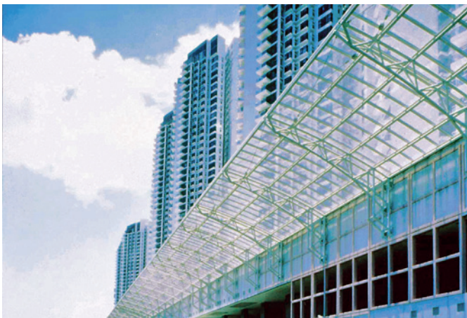
Lärmschutzwand, Ho Lung Tao PLEXIGLAS® Soundstop XT Active Way Ltd.
