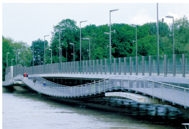
Lärmschutzwand, Donaubrücke, Ingolstadt PLEXIGLAS® Soundstop GS CC Fa. Markus Kaiser
