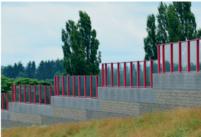
Lärmschutzwand, Pirmasens PLEXIGLAS® Soundstop GS CC, 15 mm
