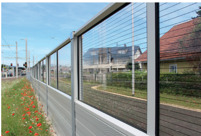
Lärmschutzwand, Regio Tram Traun Versuchsstrecke PLEXIGLAS® Soundstop GS CC Forster Metallbau Gesellschaft m.b.H. Traun
