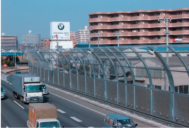
Lärmschutzwand, Obara PLEXIGLAS® Soundstop GS CC Tokyo Rope Ltd.
