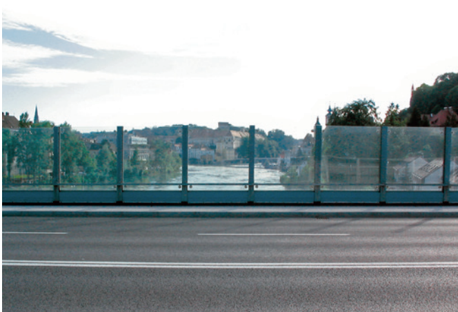
Lärmschutzwand, Rederbrücke, Steyr PLEXIGLAS® Soundstop GS CC STRABAG-Thalgau, Forster Lärmschutz Elemente, Forster Metallbau Gesellschaft m.b.H.
