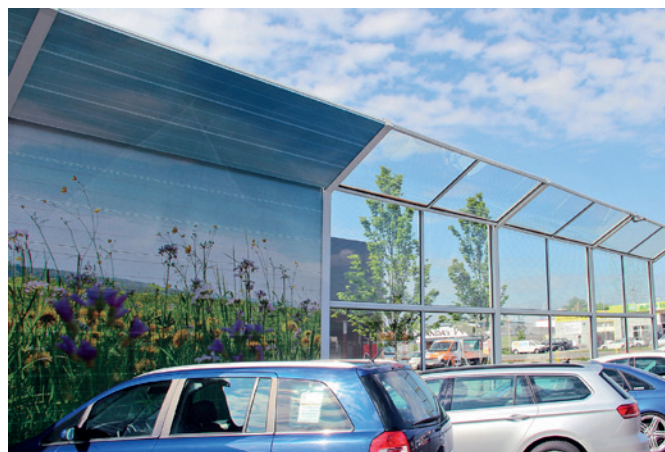
Bedruckte Lärmschutzwand PLEXIGLAS® Soundstop GS CC Forster Metallbau Gesellschaft m.b.H. St. Pölten
